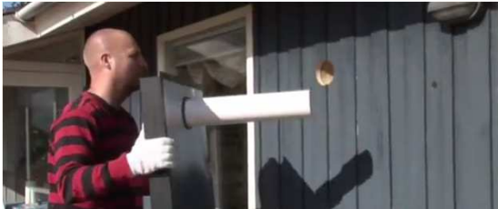
スリーブ管を付けた本体を仮で設置する。
