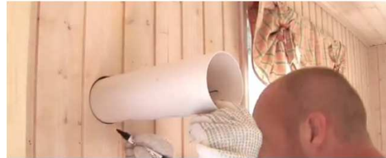
室内側からはみ出た、スリーブ管をマーキングする。
