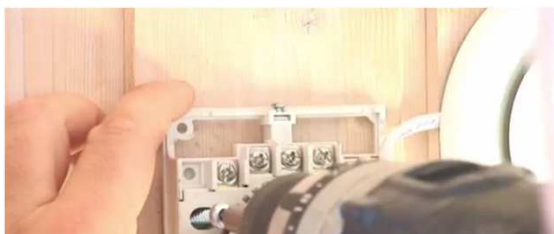
コントローラー取付
