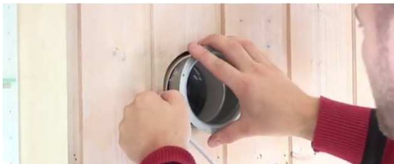
スリーブキャップの取付
