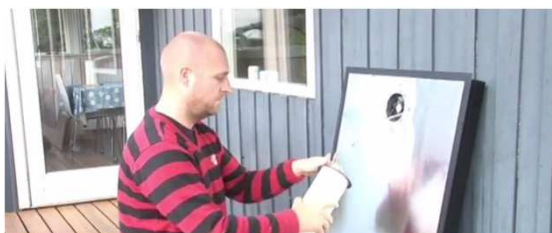
換気ファンから出ている配線をスリーブ内に通す。
