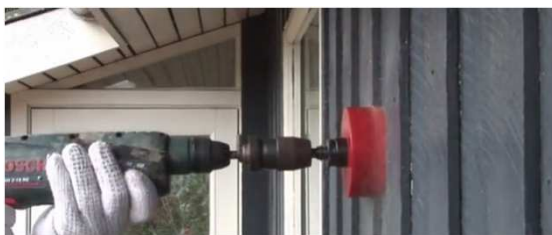
Φ100mmのホルソーを使って、外壁から穴を開ける
