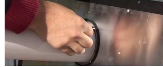
スリーブ管を本体に取付ける。
