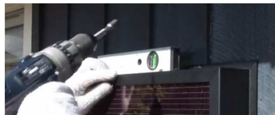
スリーブ管を取付けた本体を設置①
