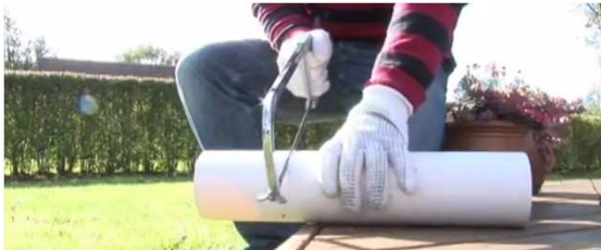
マーキングしたスリーブ管をカットする。
