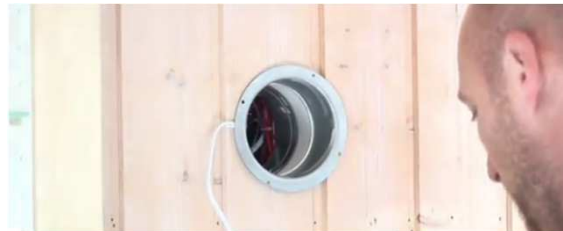
スリーブキャップの取付完成
