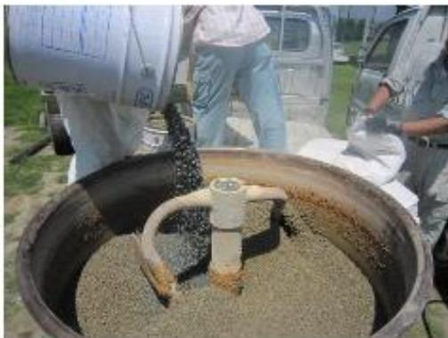
骨材(7号碎石・ピリ砂利)を90kg投入します。
