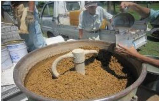
硬化液・粉袋が馴染んできたら水を加えていきます。(加水の水量は7リットルです)
