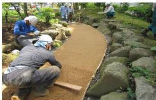
砕石転圧の上に練り上げた材料を敷均し、3cm厚で金コテなどを使用して仕上げていきます。ムラにならないように均一に抑えていきます。
