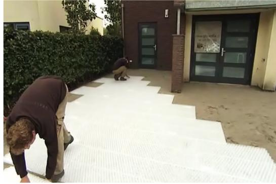
②グラベルフィックスプロの不織布は片側が長くなっておりまして、**長手・短手ともに30mm程度の隙間を空けて並べてください。** 本体同士の連結は重ねるだけで連結ができますので、下地の砂が見えないように並べてください。
